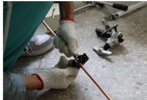
▲同學們認真地切割銅管進行冷媒管包覆，並用保溫膠帶包好，這些步驟與技巧，都得多做多練習，才能更融會貫通。
