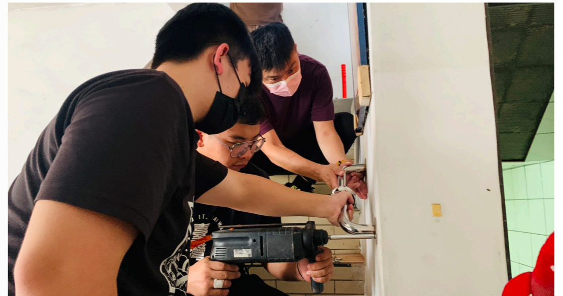
▲埔里高工機械科同學們協助社區長輩安裝家中浴廁及樓梯扶手，實踐技藝學習動手做的精神。
